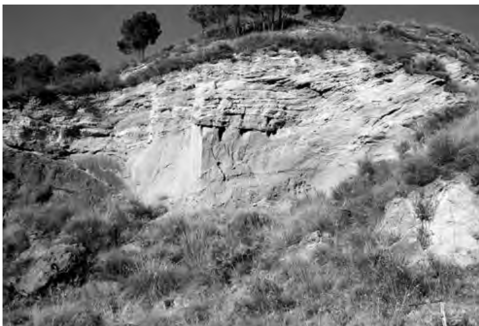
fig. 6 – Località Soforio di Armo (Gallina, RC). Fronte di cava.
