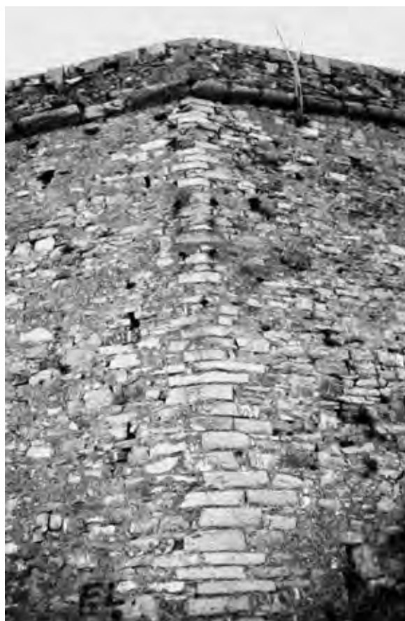
fig. 3 – Un esempio di muratura "disordinata": le Mura del XVII secolo.
