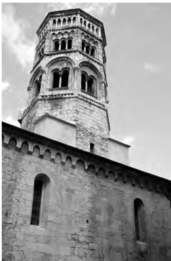
fig. 2 – Un esempio di muratura in conci squadrati: la chiesa di San Donato (XII secolo).
