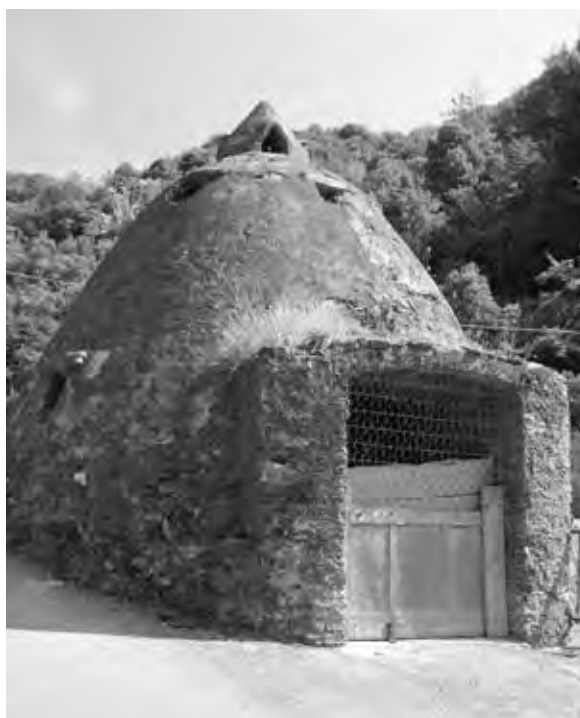
fig. 8 – Fornace da calce a funzionamento intermittente in località Bianchetta (Genova – Sestri Ponente).
