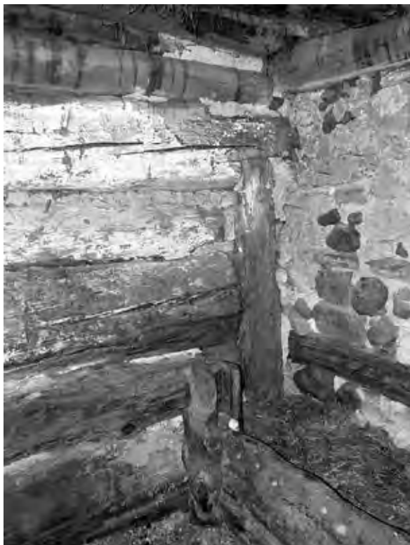
fig. 6 – Particolare dell'angolo interno nord-ovest dell'edificio di prima fase: sono visibili la parete in legno UE3 in connessione con UE1, la mangiatoia in uso e l'elemento murato nella parete perimetrale nord.
