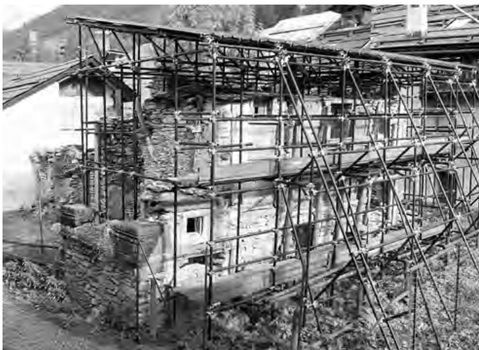
fig. 1 – La Casa delle Lapi allo stato attuale, dopo i lavori di messa in sicurezza della facciata occidentale.
