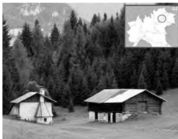
fig. 1 – Il complesso insediativo analizzato composto da casera e stalla-fienile.
