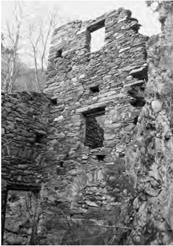
fig. 3 – Salbertrand, Oulme, grande complesso molitorio, con mulino, pesta, forgia, locali per l'immagazzinamento e la residenza.
