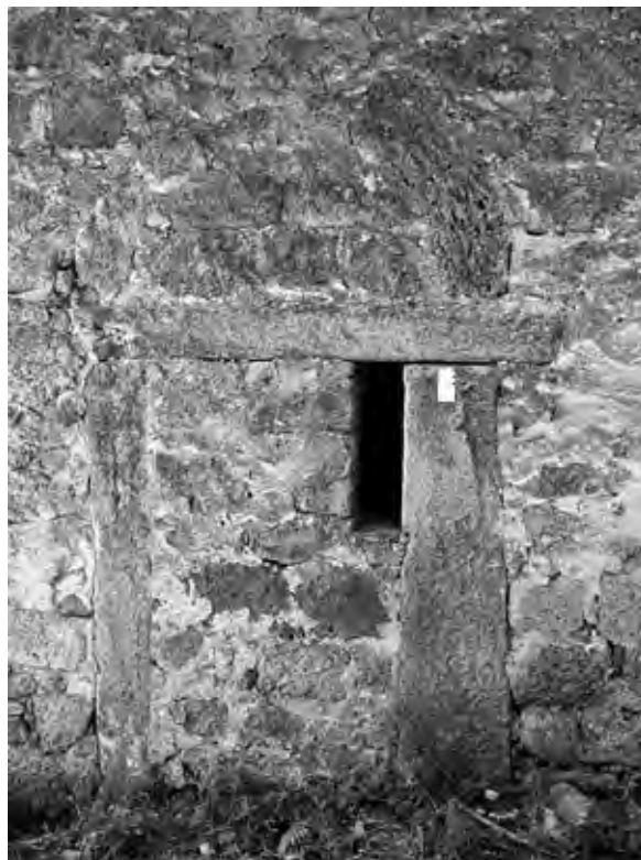
fig. 7 – Campione murario 2 (seccatoio di San Biagio di Gravilona).
