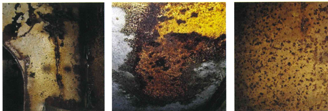
Figura 5 - Da sinistra: esempio di cricca, corrosione e vaiolatura (pitting) nelle strutture della testing facility. Figure 5 - From the left: example of crack, corrosion and pitting occurring in the testing facility structures.
