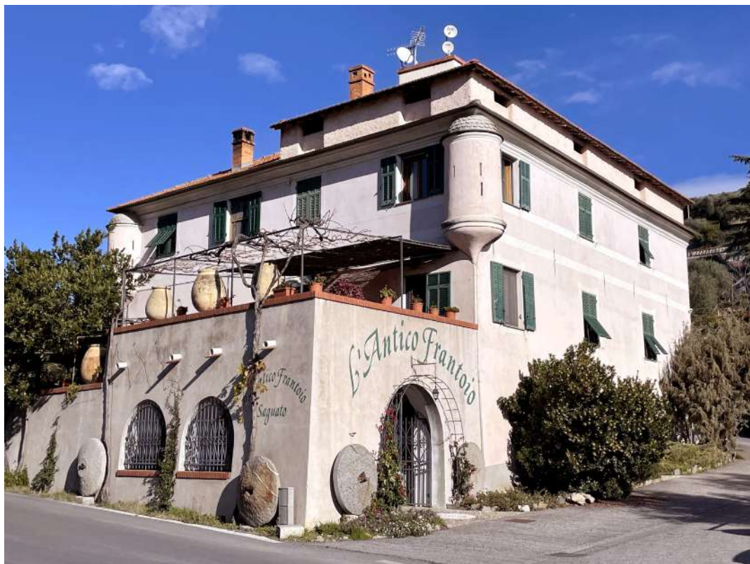
Fig. 3 – Azienda agricola «L'antico frantoio», già convento fortificato alle porte del borgo di San Pietro
