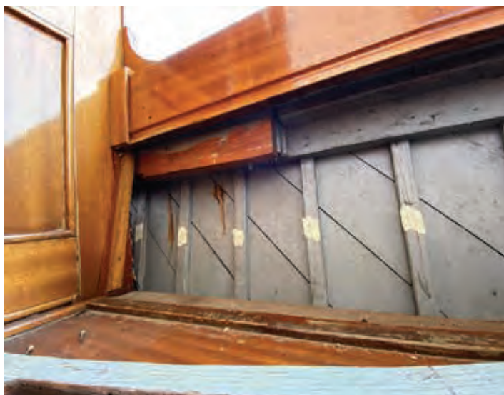
Figure 37-41. In questa pagina e nella successiva. Esempi di documentazione fotografica delle strutture: chiglia, correnti, fondo e madieri a poppa, dettaglio fianco, dettaglio madiere, dettaglio correnti, fianco, dettaglio correnti e cinta a prua (Credits: Ottavia Giordano, Valentina Malagnini, Serena Navisse, Andrea Vitali)
