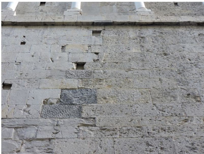
Figura 1. Genova, Cattedrale di San Lorenzo, integrazioni dei paramenti e dei rivestimenti lapidei compiuti in diversi momenti tra la fine del XIX secolo e la seconda metà del XX. In questa immagine vediamo una integrazione di conci lapidei eseguita con lo stesso materiale, un calcare marnoso, e resa distinguibile grazie alla differente lavorazione superficiale, (foto L. Napoleone, 2024).
