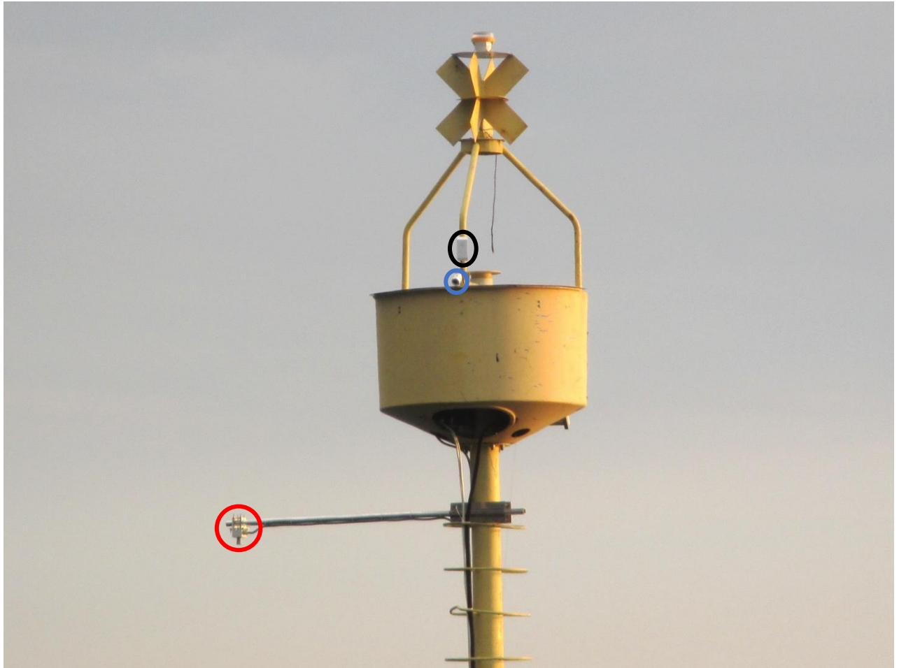
Figura 4.17 Cestello e sensoristica in superficie
