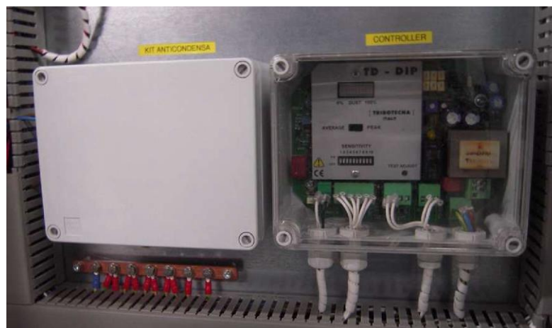
Figura 2.4 Centralino di controllo ed unità di alimentazione del kit anti-condensa
