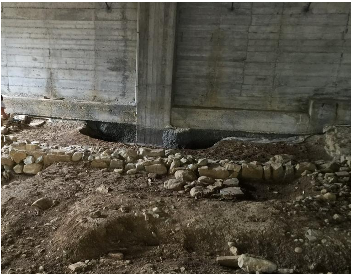
Figura 106: Dettaglio delle murature dell'edificio scolastico impostate sopra i resti dei Vani I e II dell'"Edificio A". La struttura portante dell'edificio scolastico si presta ad una serie di interventi per la musealizzazione.
