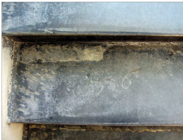
5. Gradino di ardesia. Sulla superficie, già usurata, è incisa la data 1736, che fornisce una datazione ante quem (scala di villa Imperiale a Terralba, San Fruttuoso).
