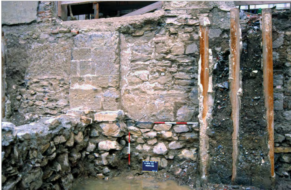
1. Murature continue di fondazione di epoca medievale (area dell'asilo Tollot, scavo Soprintendenza Archeologica della Liguria, direzione dott.ssa Piera Melli, esecuzione Aran Progetti, da Archivio MIC-SABAP, già pubblicata in GALLIANI, MOR 2006, p. 52).
