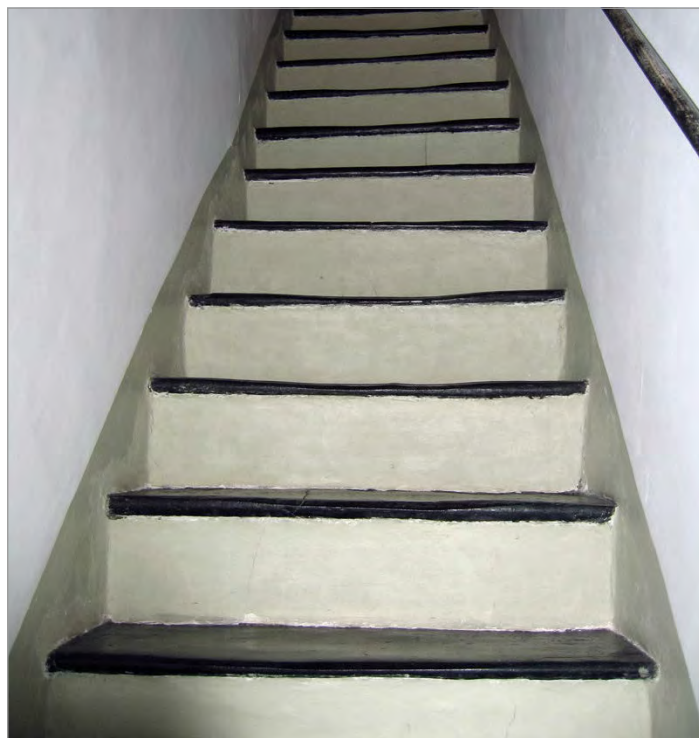
1. Scala a rampa singola tra muri d'ambito, con pendenza accentuata (edificio in via San Luca).
