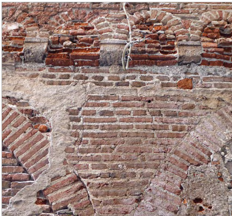
8. Muratura in mattoni con giunti di malta lisciati (edificio in vico Fate, XIV secolo).
