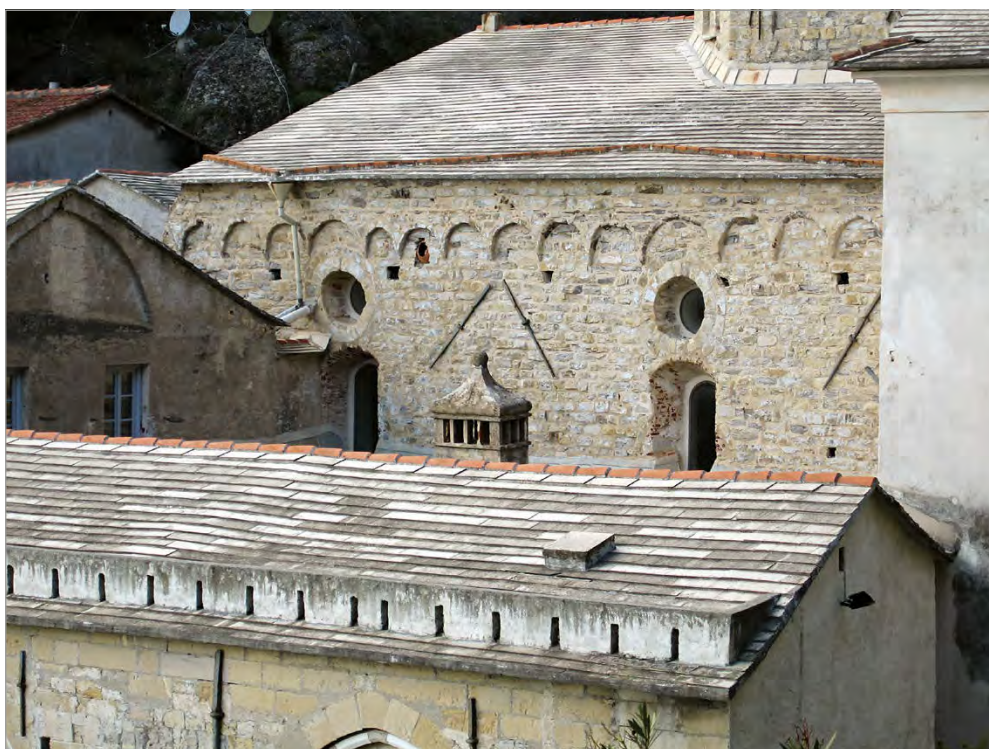
8. Ghiane contemporanee e muretti d'attico sui tetti del monastero di San Fruttuoso di Capodimonte.
