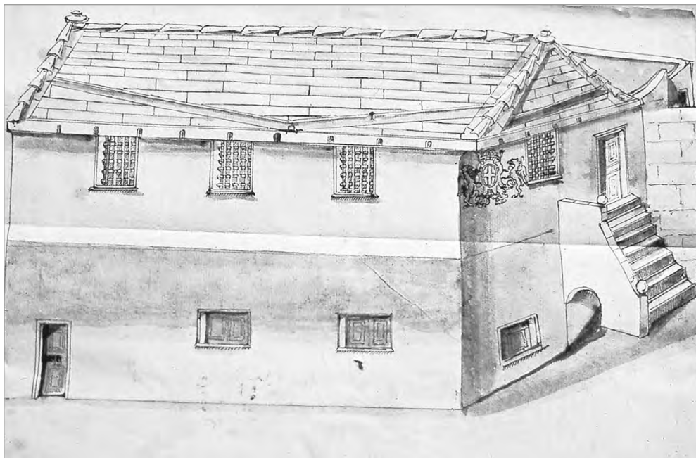
7. Magazzino del grano a Calvi (Archivio di Stato di Genova, Corsica, n. 553, 1625). Sul tetto si nota la presenza di muretti obliqui per il convogliamento dell'acqua piovana (le cosiddette ghiane ).
