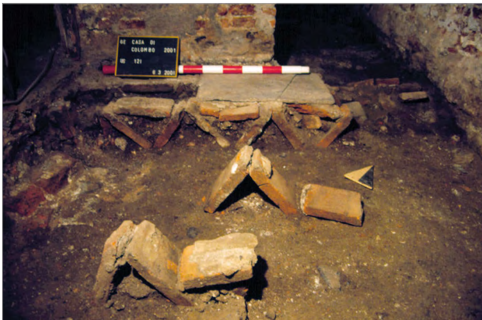
2. Vespai in mattoni disposti a castello di carte (casa di Colombo, scavo Soprintendenza Archeologica della Liguria, cfr. MELLI, TORRE 2002) (da Archivio MIC-SABAP, già pubblicata in GALLIANI, MOR 2006, p. 54).
