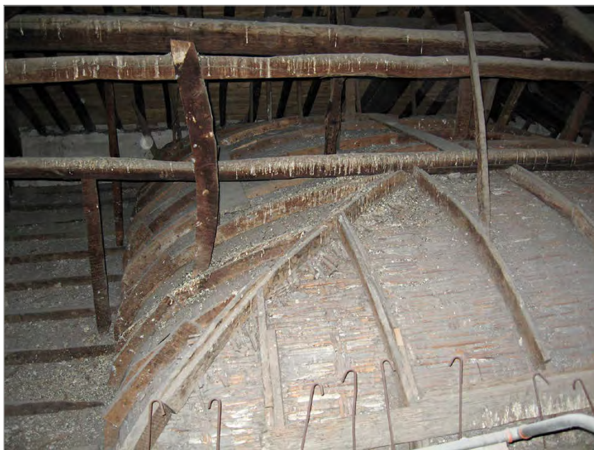
3. Estradosso di volta e soffitto piano in legno e canniccio (palazzo Grillo in piazza delle Vigne).
