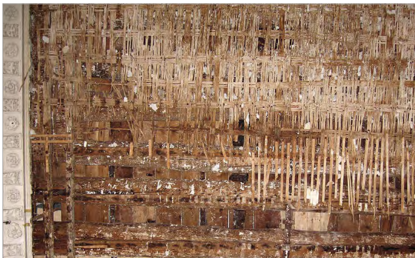
4. Intradosso di controsoffitto piano in canniccio. Si nota una integrazione in listelli di legno (palazzo Grillo in piazza delle Vigne).
