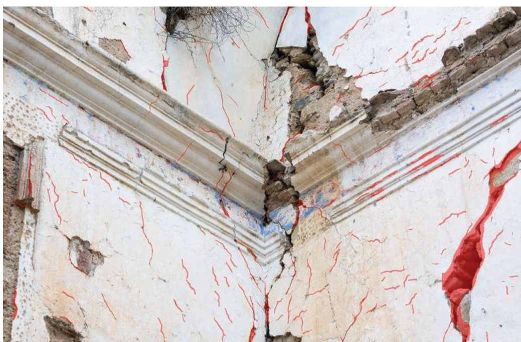
Fig. 4. A sinistra, l'immagine originale (fotografia degli autori, 15 gennaio 2023). A destra, l'immagine processata all'interno di YOLOv7. Si noti come la maggior parte delle fessurazioni, in rosso, siano state identificate.
