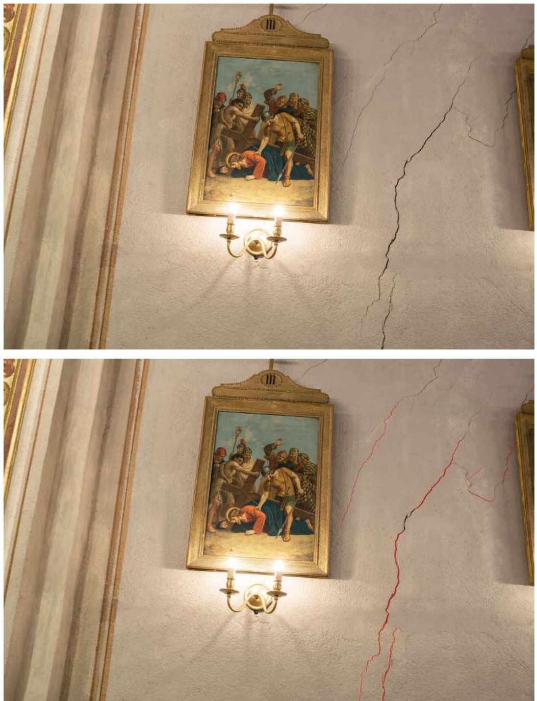
Fig. 6. Elaborazione delle immagini costituenti il dataset necessario alla realizzazione del modello tridimensionale della Chiesa di San Carlo Borromeo a Cassinghen. In alto, l'immagine originale. In basso, l'immagine processata all'interno di YOLOv11.
