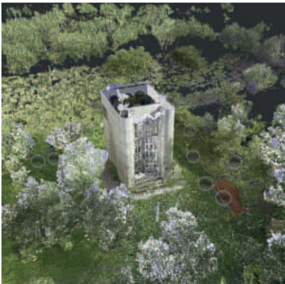
Figura 4: Banca dati delle scansioni laser acquisita sia all'interno che all'esterno del mausoleo.
