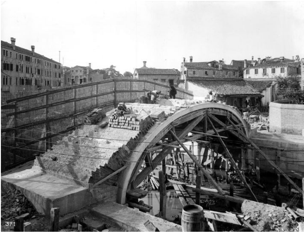
6: Autore ignoto, Rio Nuovo – Costruzione del Ponte de la Ceraria, 1932 [Archivio fotografico del Comune di Venezia, Fondo Giacomelli, identificativo immagine n. GN006800].
