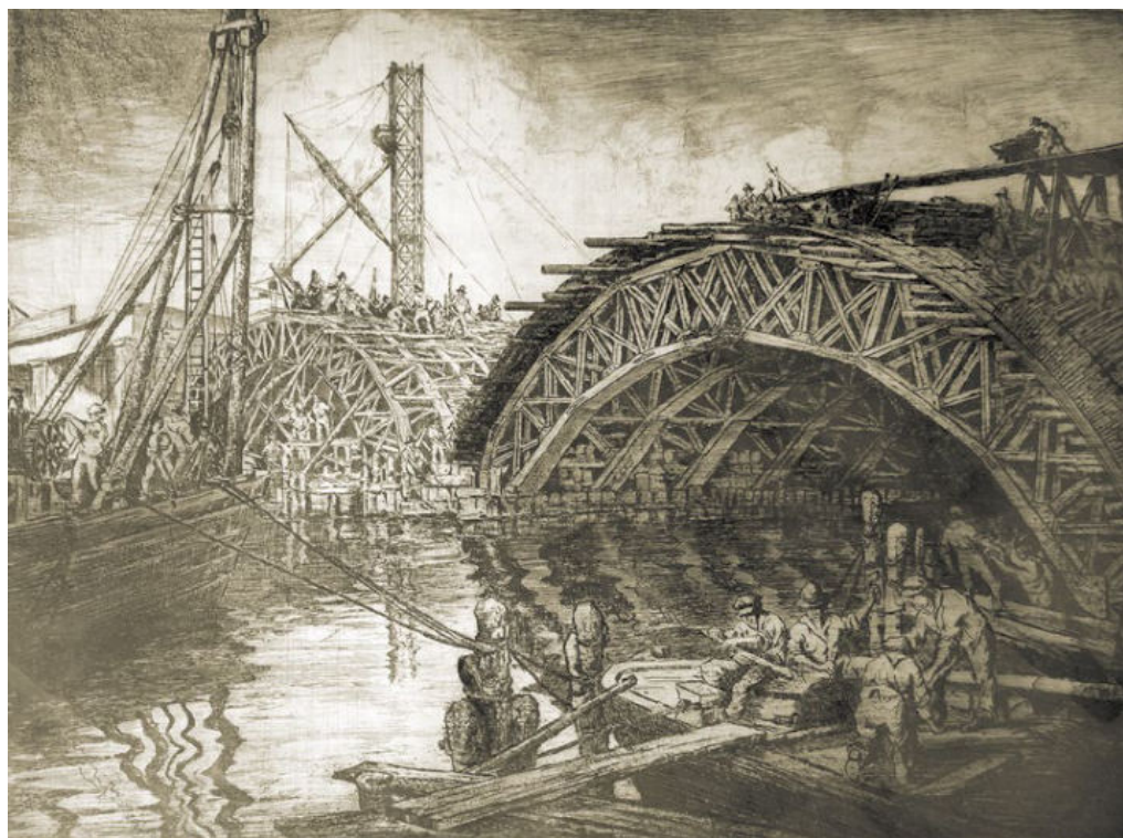
3: Giovanni Giuliani, Ponte Littorio - Costruzione del Cavalcavia , 1932-1933 [collezione privata].
