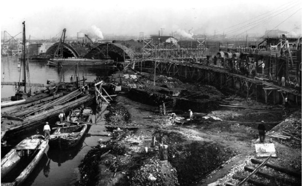
4: Ponte lagunare - Costruzione delle rampe a Venezia, 1932 [Archivio fotografico del Comune di Venezia, Fondo Giacomelli, identificativo immagine n. GN003240].
