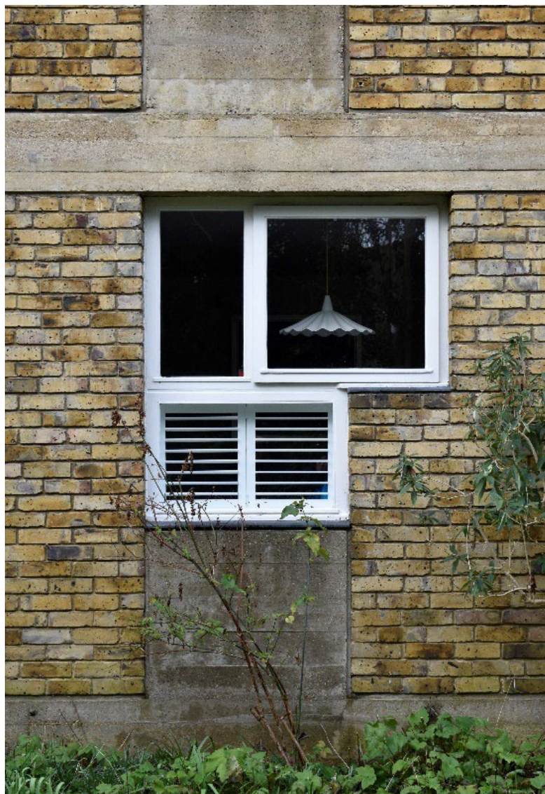
Fig. 12. Appartamenti di Ham Common. Dettaglio.
