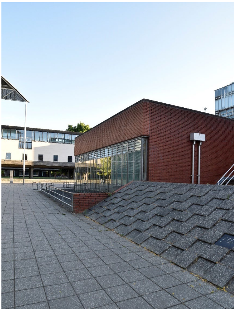
Fig. 37. History Faculty Library, University of Cambridge. Dettaglio della base della facciata vetrata della Seeley Library. Area attualmente soggetta a interventi di ristrutturazione.
