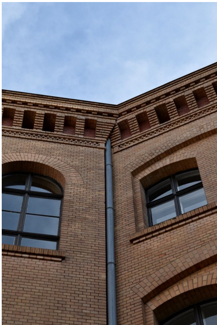
Fig. 128. Dettaglio della muratura storica della preesistenza, con cornici e modanature in laterizio.
