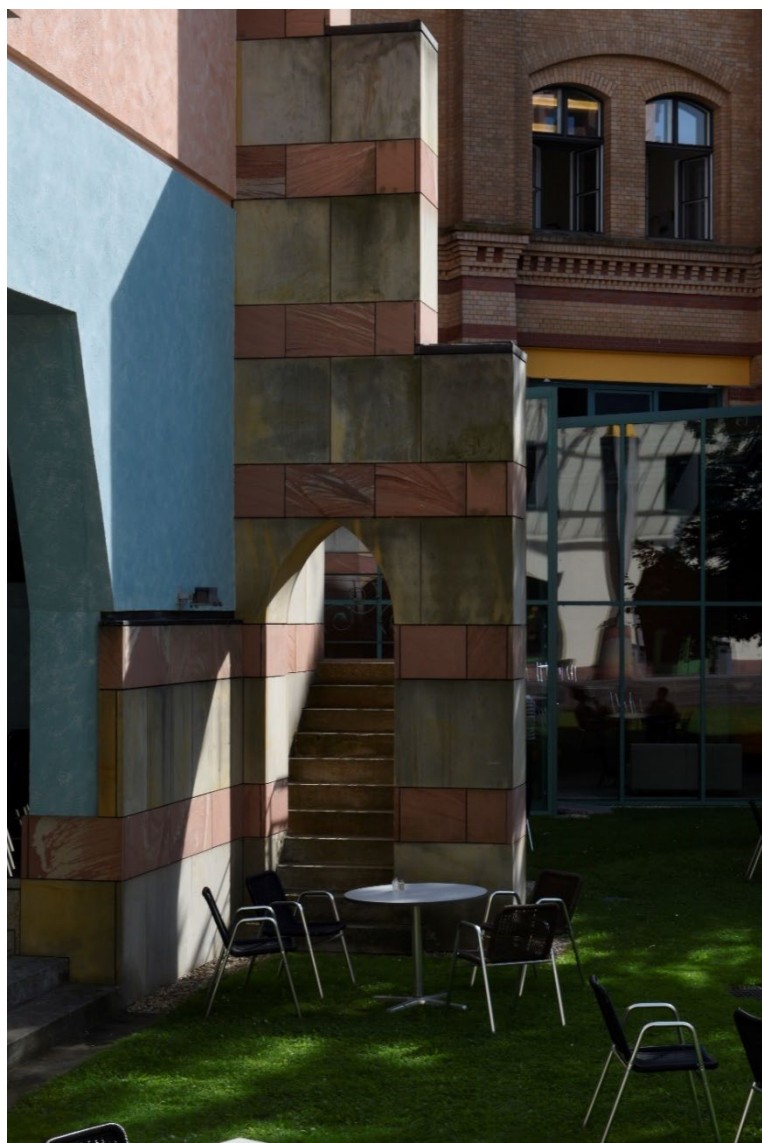
Fig. 118. Scala e arco in pietra artificiale nella corte: dettaglio dell'innesto laterale.
