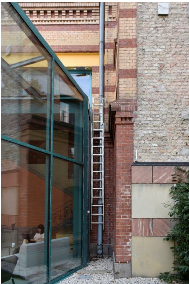
Fig. 130. Giunto tra la facciata in vetro del nuovo intervento e l'edificio storico.
