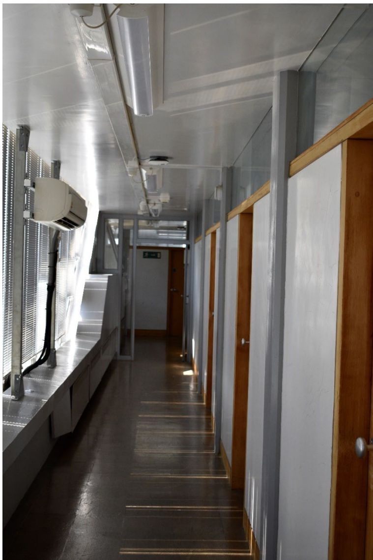
Fig. 43. History Faculty Library, University of Cambridge. Corridoio dell'ultimo piano del blocco a "L", in corrispondenza degli uffici.
