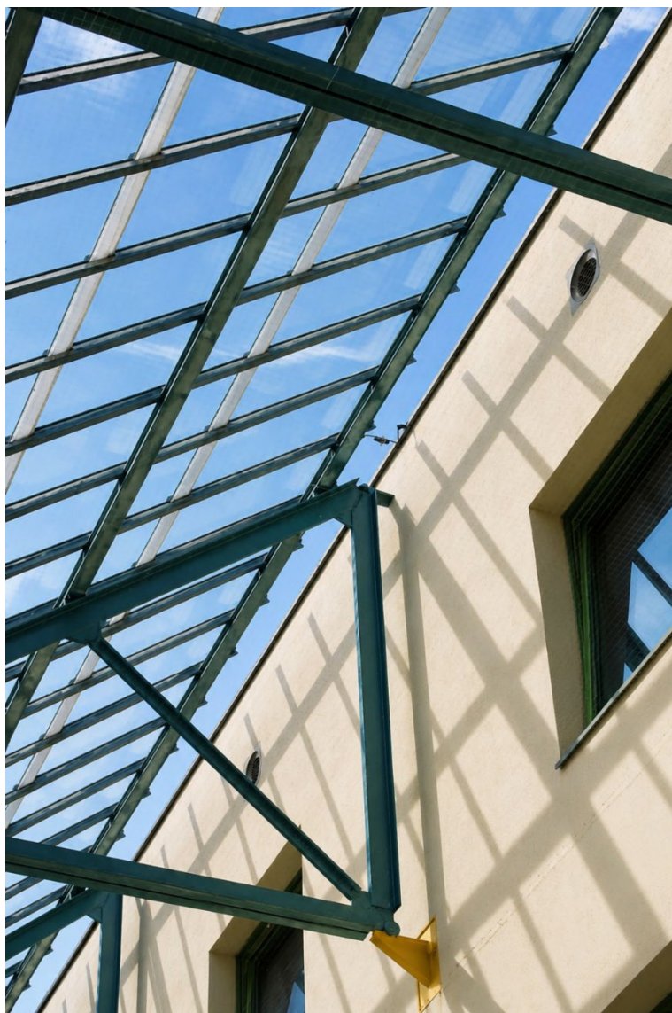
Fig. 139. Struttura metallica della pensilina vetrata.
