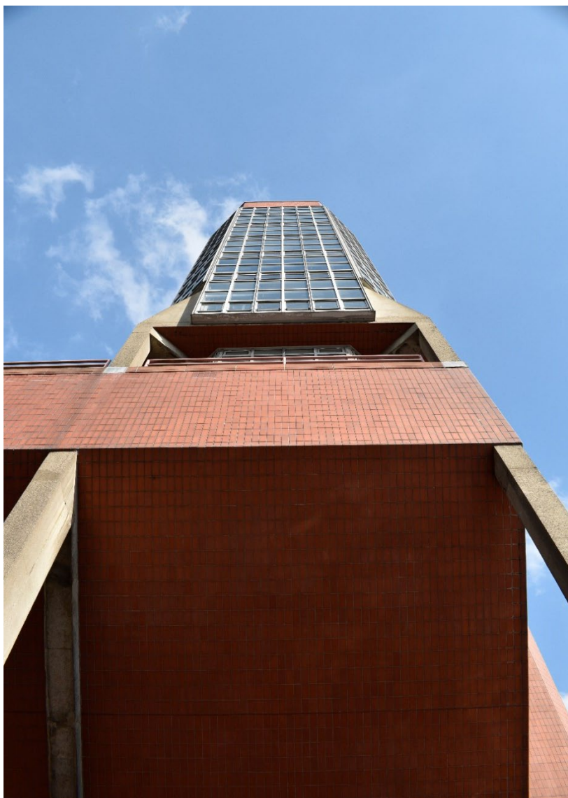
Fig. 23. Fotografia dell'estradosso della pianta.
