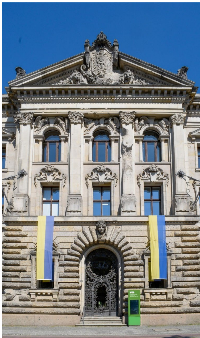
Fig. 114. Accesso all'edificio dal fronte ottocentesco su Reichpietschufer.
