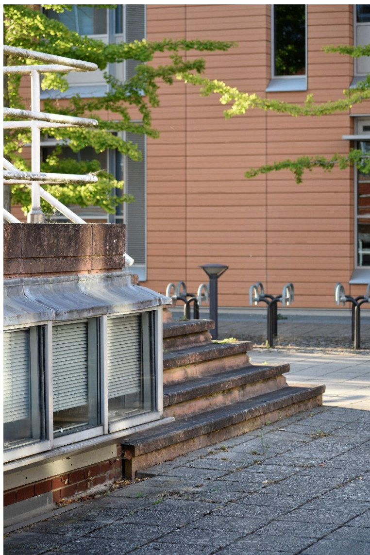
Fig. 36. History Faculty Library, University of Cambridge. Area attualmente soggetta a interventi di ristrutturazione.
