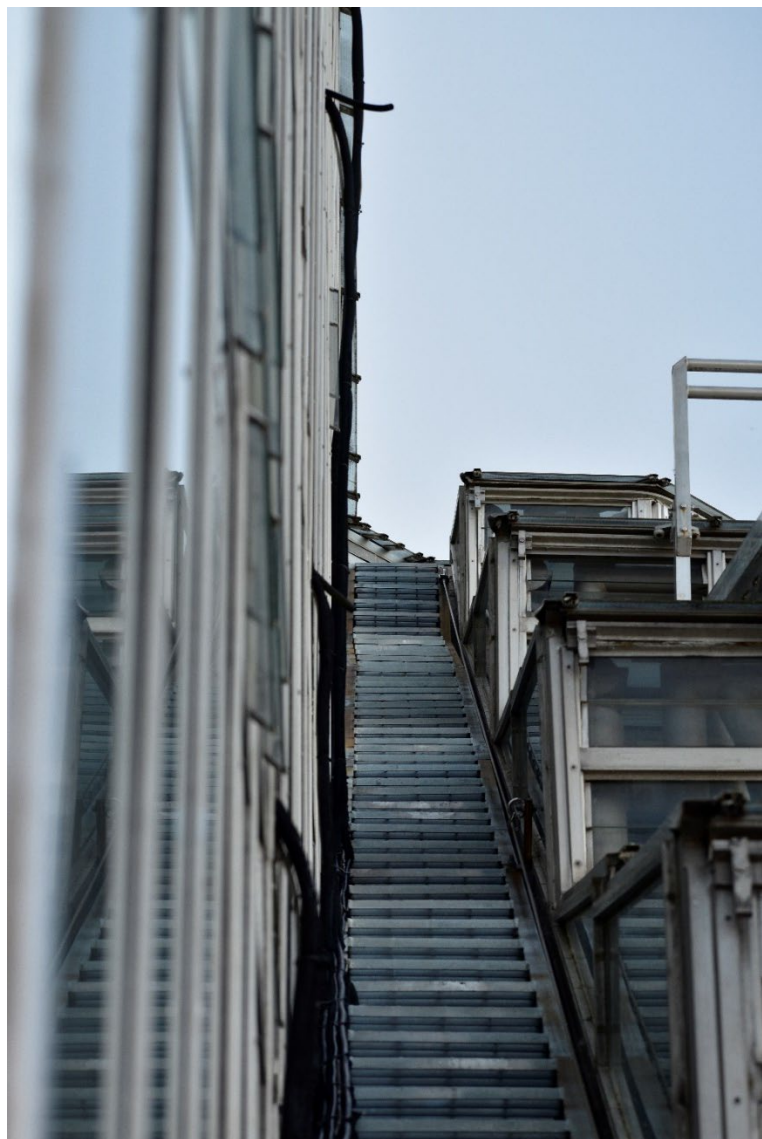
Fig. 40. History Faculty Library, University of Cambridge. Scala di servizio sul tetto della Seeley Library.
