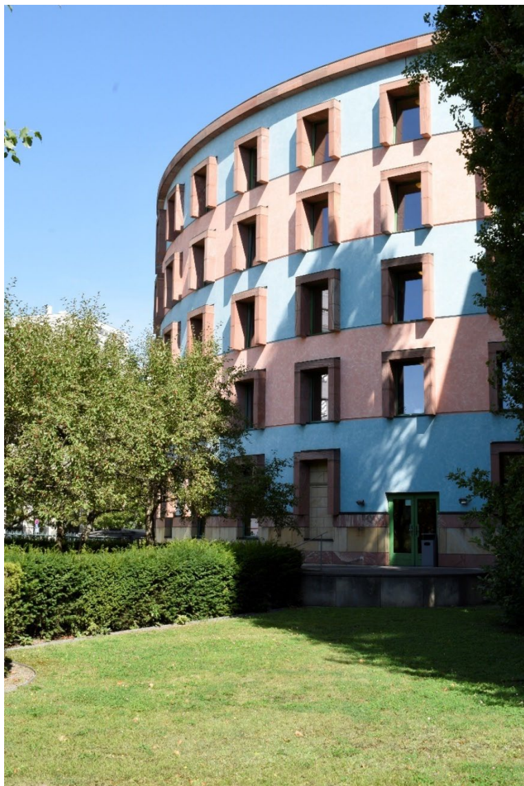
Fig. 113. Facciata curva del nuovo edificio sulla corte, "il teatro", con fasce rosa-azzurre e strombature delle finestre in pietra.
