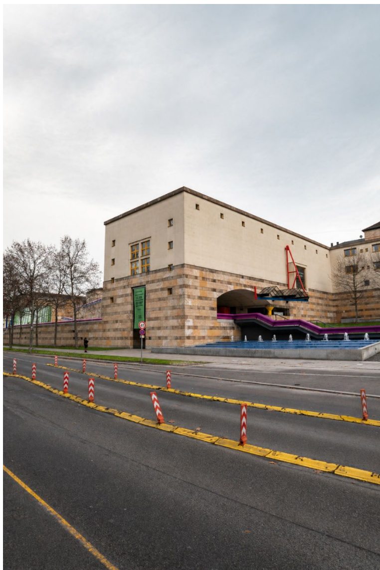
Fig. 98. Neue Staatsgalerie, Stoccarda. Fronte stradale.
