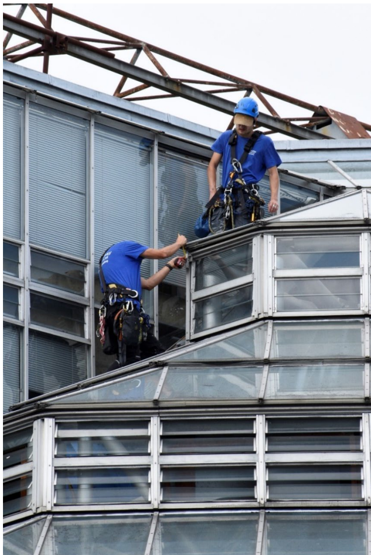
Fig. 39. History Faculty Library, University of Cambridge. Operazioni di rilievo e misurazione della facciata vetrata nell'ambito degli interventi di restauro in corso (agosto 2024).
