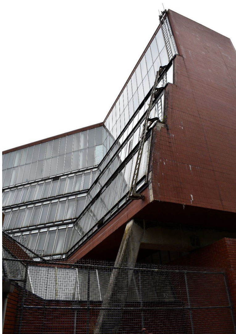
Fig. 56. Florey Building, Oxford. Vista dal fiume sulla corte centrale.
