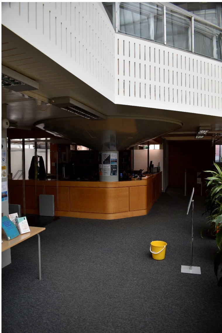
Fig. 51. History Faculty Library, University of Cambridge. Vista del pilastro conico sovradimensionato che sostiene il blocco a "L".
