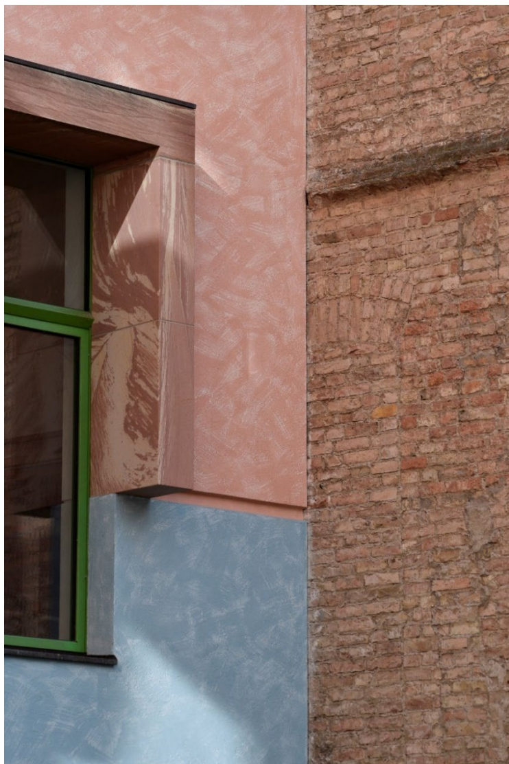
Fig. 120. Dettaglio del serramento verde e della cucitura tra nuovo e preesistente, con arco tagliato.
