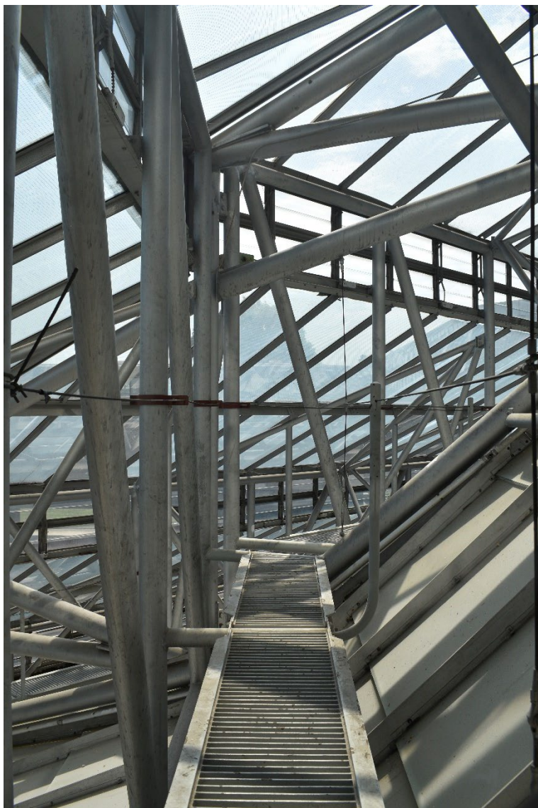
Fig. 41. History Faculty Library, University of Cambridge. Interno della struttura di copertura della Seeley Library.
