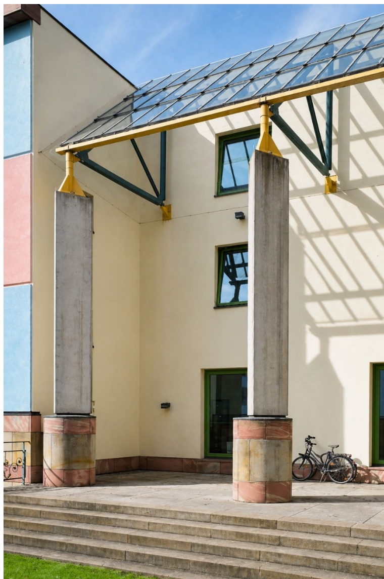
Fig. 138. Pensilina interna alla corte.
