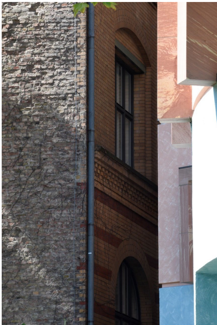
Fig. 131. Incastro tra muratura storica e volume di Stirling, evidenziato dalla differenza materica.
