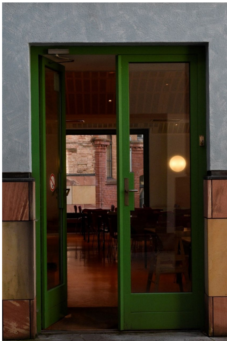
Fig. 122. Soglia di accesso dalla corte interna alla "basilica", zona pranzo, con accesso tramite serramento verde.
