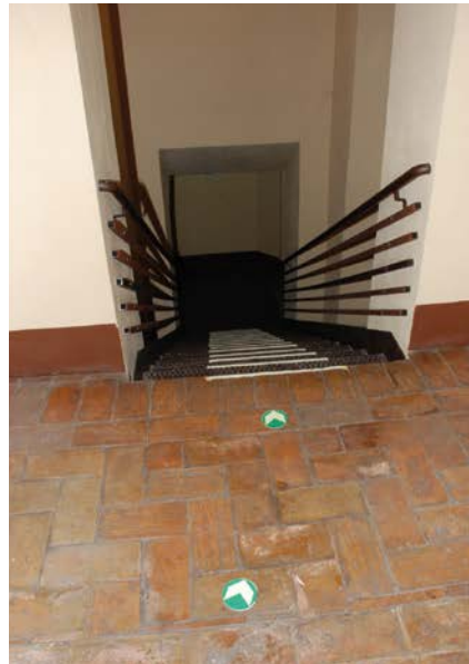
Fig. 10 - A sinistra, la vista della prima fila della platea con la segnaletica a pavimento; a destra, parte del percorso al piano secondo, con corridoio di piano e scale marcate, alla fine di ogni gradino, dalle strisce fotoluminescenti (da Bernardini, D'Orazio, Quagliarini, Soluzioni di wayfinding non invasive per aumentare la sicurezza antincendio negli edifici storici , 2017)
