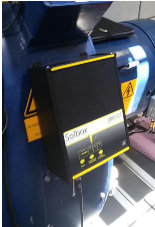
Fig. 6.6 Antenna posizionata sul lato T2
