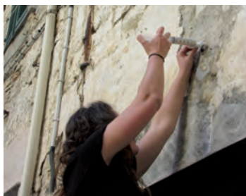
Fig. 55 - Riadesione di una lente di distacco con iniezione di malta compatibile
