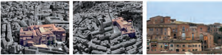
Fig. 117 - Inquadramento del complesso architettonico nel contesto urbano e vista d'insieme
