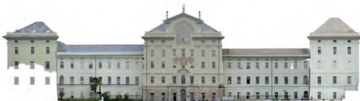
Fig. 133 - Fotoraddrizzamento del prospetto principale dell'Albergo dei Poveri
