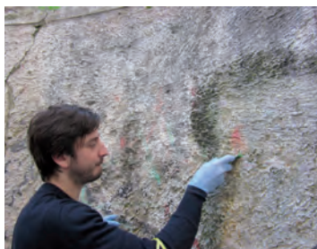
Fig. 54 - Gli specializzandi sperimentano le tecniche di restauro sugli intonaci: pulitura dei graffiti
