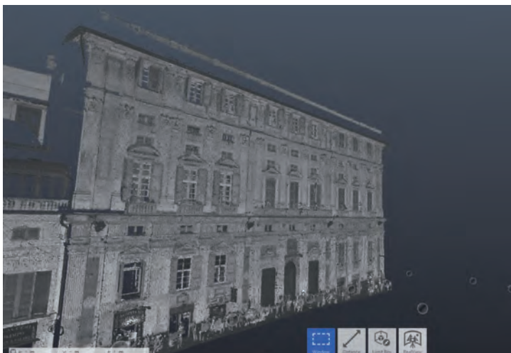
Fig. 3 - Vista della nuvola di punti ottenuta tramite rilievo laser scanner. Palazzo Belimbau, facciata su piazza della Nunziata, Genova
