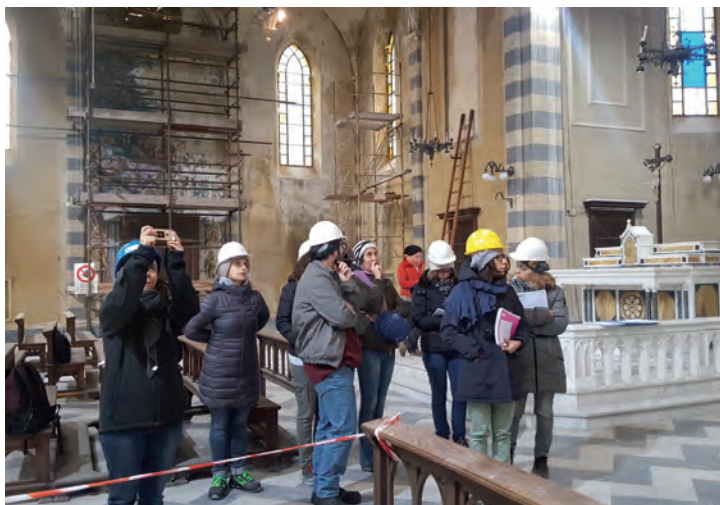
Fig. 65 - Visita al cantiere di restauro dei dipinti di Gino Grimaldi nella chiesa di S. Maria Addolorata nell'ex Ospedale Psichiatrico di Cogoleto
