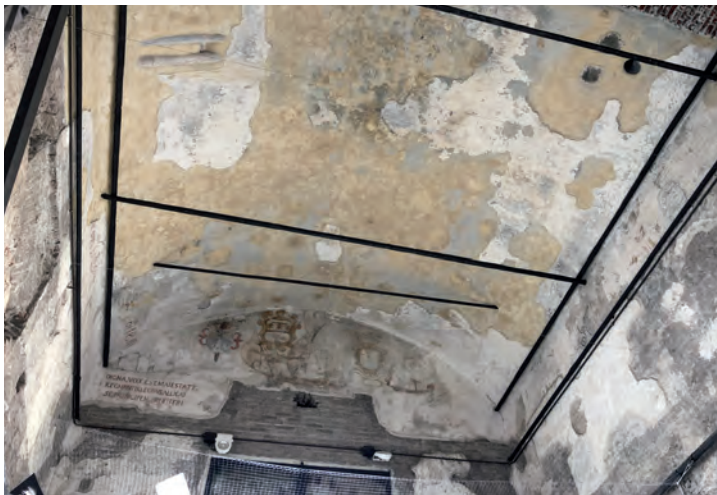
Fig. 20 - Veduta della volte a botte di uno degli ambienti della Torre
