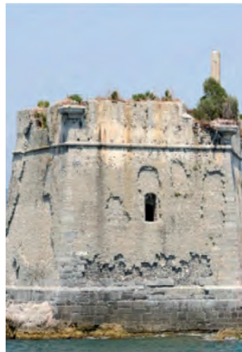
Fig. 79 - Veduta di Torre Scola
