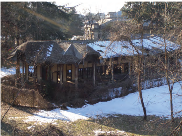
Fig. 184 - Veduta dello stato di forte degrado in cui versava uno dei padiglioni del complesso del ex Sanatorio Regina Elena di Savoia
