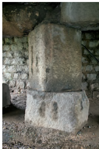
Fig. 180 - Particolare di uno dei pilastri lapidei del ponte
