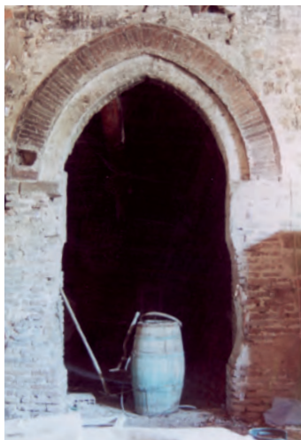
Fig. 231 - Particolare di una bucatura con arco a sesto acuto
