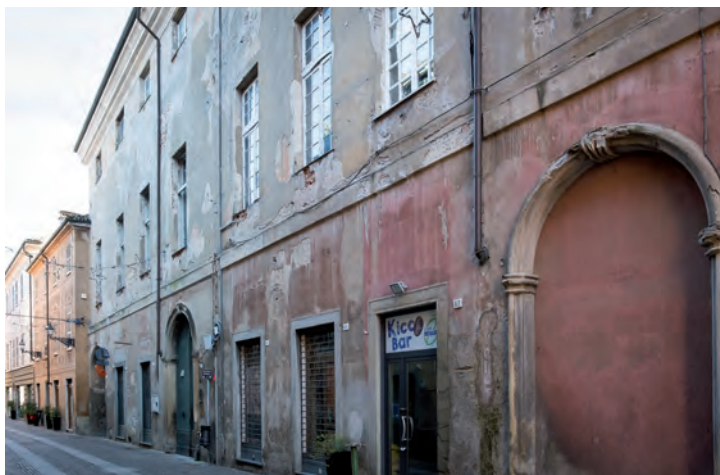
Fig. 202 - Veduta della facciata di Palazzo Brignole su via Roma
