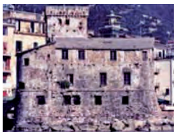
Fig. 267 - Il castello prima dei restauri
