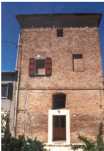
Fig. 230 - Particolare della facciata dell'edificio a torre
