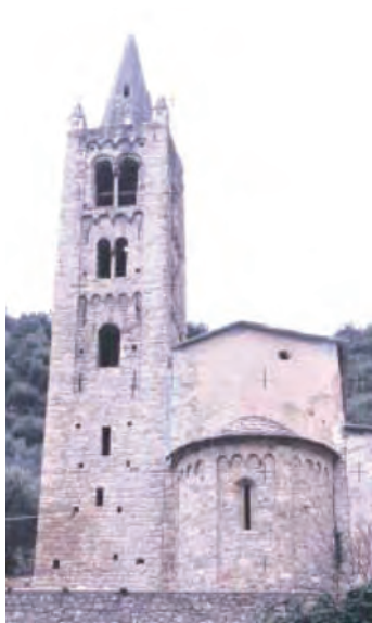
Fig. 214 - Veduta dell'abside e del campanile della ex chiesa
