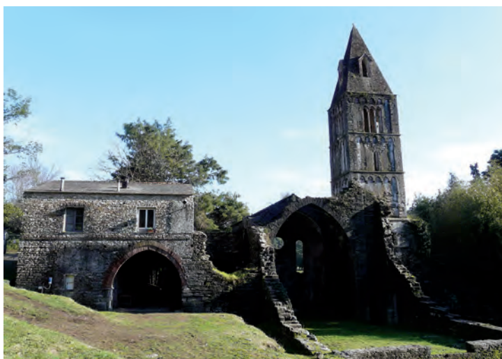
Fig. 249 - Veduta del complesso monumentale dell'abbazia di Santa Maria in Valle Christi a Rapallo
