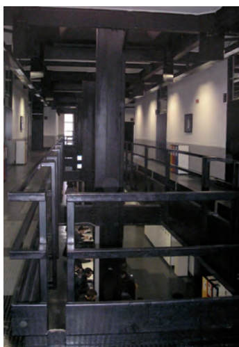
Fig. 159 - Veduta del sistema a ballatoio al secondo piano dell'edificio
