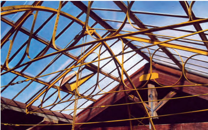
Fig. 241 - Particolare della struttura in ferro a sostegno del lucernaio del tetto
