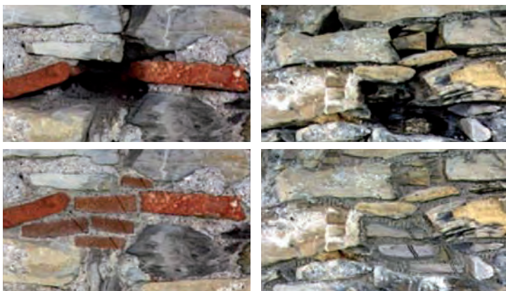
Fig. 258 - Simulazione dell'intervento di integrazione della tessitura muraria tramite inserimento di materiale lapideo e stuccatura dei giunti
