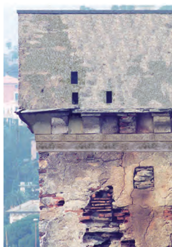
Fig. 272 - Simulazione dell'intervento di consolidamento tramite cerchiaggio con fascia in carbonio successivamente intonacata
