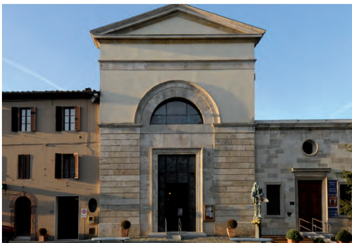
Fig. 222 - Veduta della facciata principale dell'Oratorio della Misericordia in Piazza Marconi, Castelnovo della Berardenga
