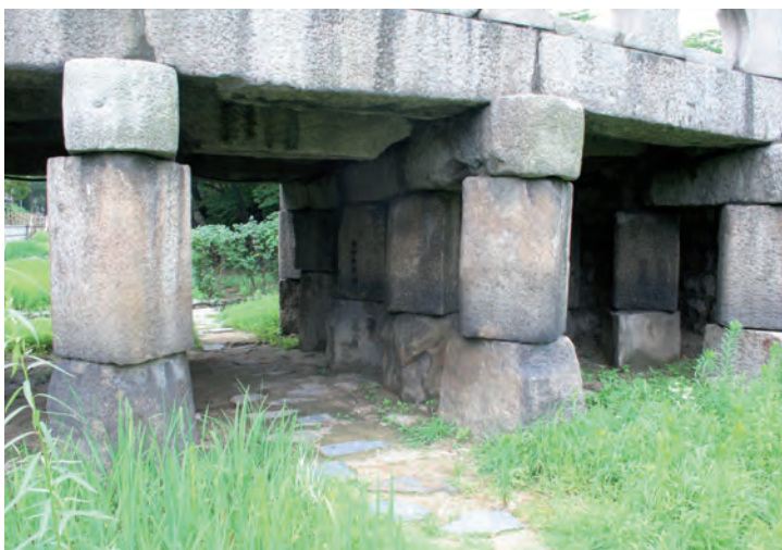
Fig. 178 - Veduta dei pilastri lapidei del ponte
