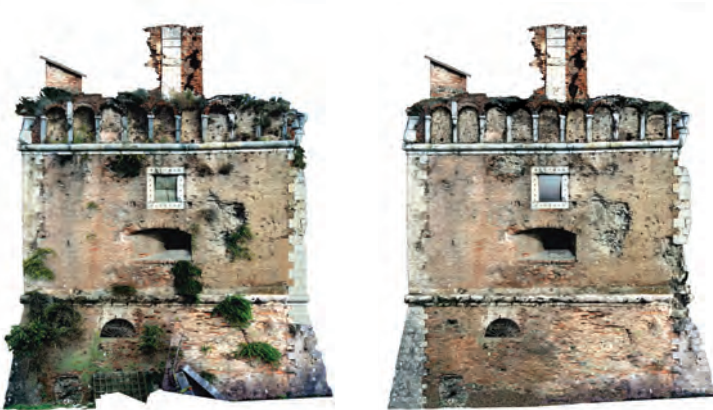
Fig. 235 - Raddrizzamento fotografico del prospetto sud. Stato di fatto ed elaborazione dell'immagine per la simulazione delle prime fasi di intervento di restauro
