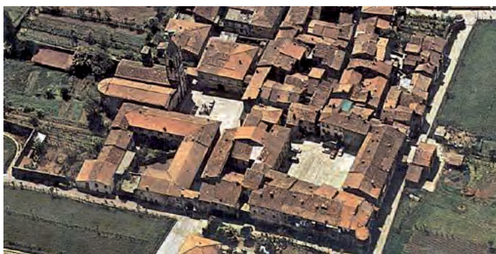
Fig. 255 - Veduta aerea del Borgo del Filetto
