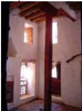
Fig. 6 Interni, in cui si vede la colonna rompi-tratta delle travi portanti dei solai e il 'capitello' di ripartizione dei carichi.
