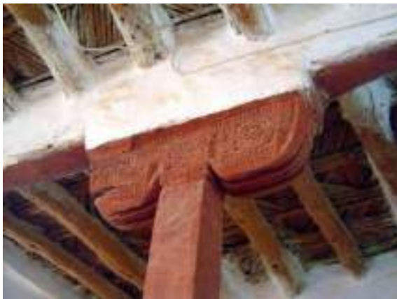
Fig. 6 Interni, in cui si vede la colonna rompi-tratta delle travi portanti dei solai e il 'capitello' di ripartizione dei carichi.
