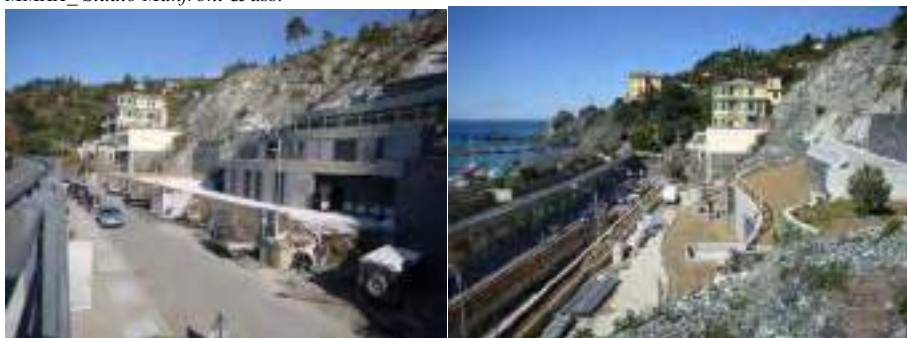
Figg.13/14 Il nuovo depuratore intercomunale di Levanto e Bonassola in costruzione (Foto di Patrizia Burlando); Il nuovo depuratore intercomunale di Levanto e Bonassola in costruzione (Foto di Mario Manfroni)
