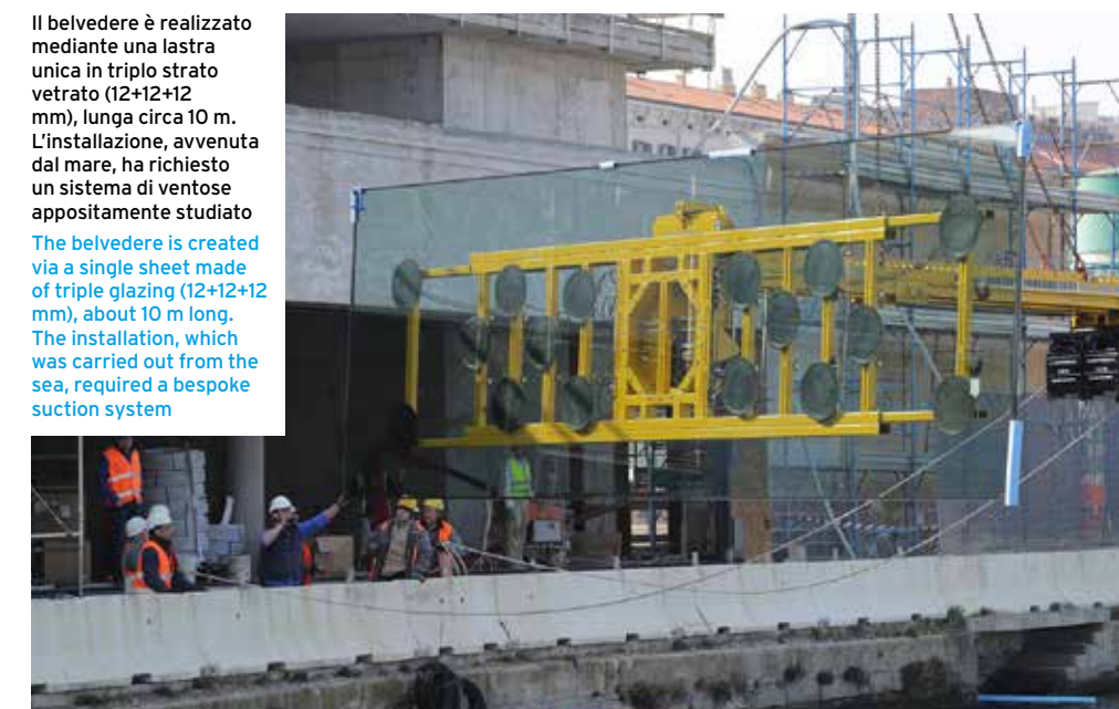
Installazione delle lastre vetrate di copertura Installation of the glazed sheets on the roof
