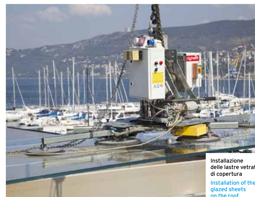
Il belvedere è realizzato mediante una lastra unica in triplo strato vetrato (12+12+12 mm), lunga circa 10 m. L'installazione, avvenuta dal mare, ha richiesto un sistema di ventose appositamente studiato The belvedere is created via a single sheet made of triple glazing (12+12+12 mm), about 10 m long. The installation, which was carried out from the sea, required a bespoke suction system
