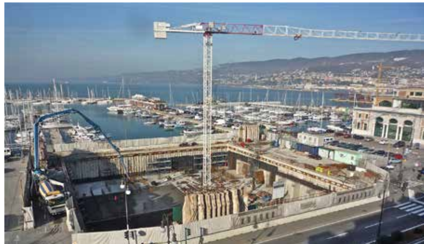
Realizzazione della platea di fondazione di calcestruzzo armato, ancorata su micropali per il contenimento della sottospinta idraulica Execution of the reinforced concrete foundation slab connected to micro piles to contain the hydraulic pressure underneath
