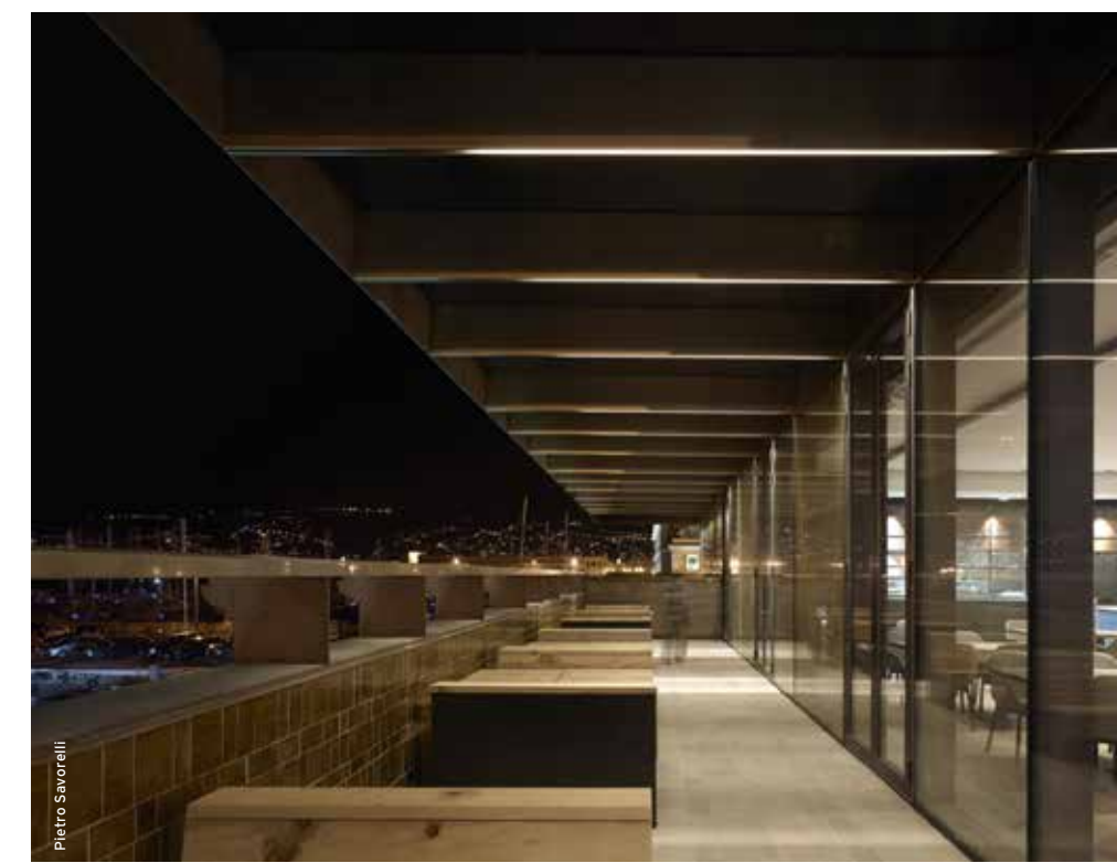
Completamento della pensilina vetrata, copertura dell'intercapedine tra l'involucro interno e i muri originari esterni Completion of the glazed canopy, cover of the gap between the internal envelop and the original external walls
