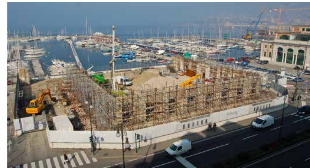
Demolizione dei manufatti presenti sul sito e del muro perimetrale antistante il mare, con messa in sicurezza delle restanti murature Demolition of the existing buildings on the site and of the perimeter wall overlooking the sea with the temporary works for the remaining walls
