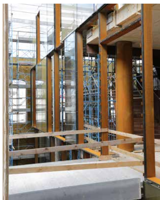
Montaggio delle carpenterie metalliche e del sistema in montanti e traversi per la realizzazione dell'involucro vetrato Installation of the metal carpentry and of the transoms and mullions system for the creation of the new glazed envelop
