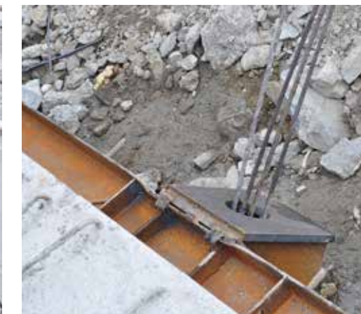
Esecuzione dei tiranti di tipo attivo a sette trefoli per vincolare in sommità la paratia di pali secanti Execution of the active seven threads rods to fasten the top of the wall to the secant piles
