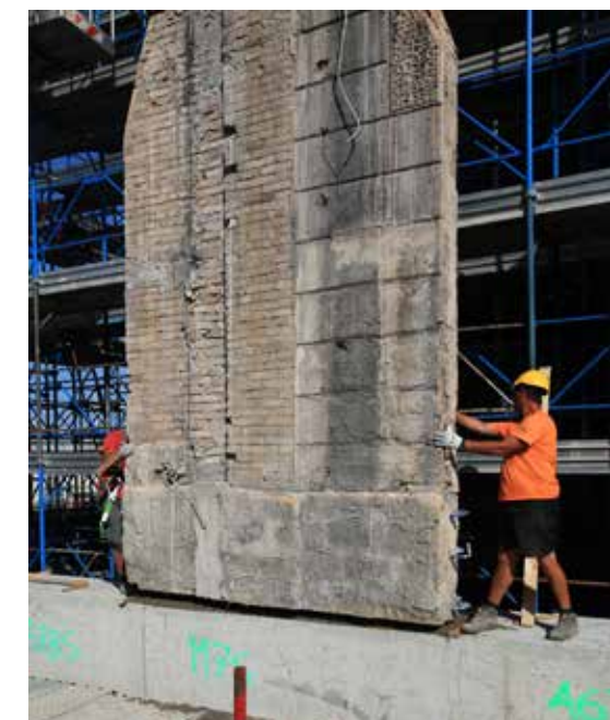
Completamento interno delle murature originarie mediante installazione del rivestimento interno in elementi vetrati retroilluminati Completion of the internal original walls via installation of an internal finish made of glazed back-lit elements
