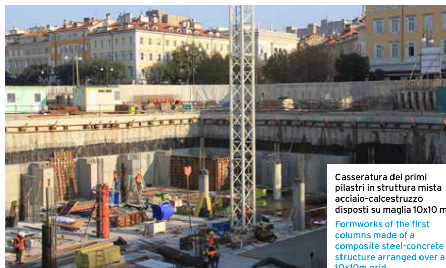
Realizzazione della platea di fondazione di calcestruzzo armato, ancorata su micropali per il contenimento della sottospinta idraulica Execution of the reinforced concrete foundation slab connected to micro piles to contain the hydraulic pressure underneath
