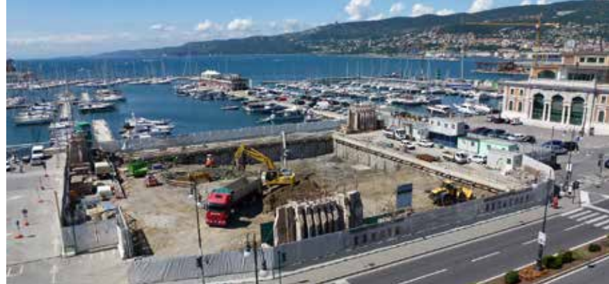
Scavo di sbancamento per il raggiungimento della quota del secondo livello interrato Excavation works to reach the second basement level's depth
