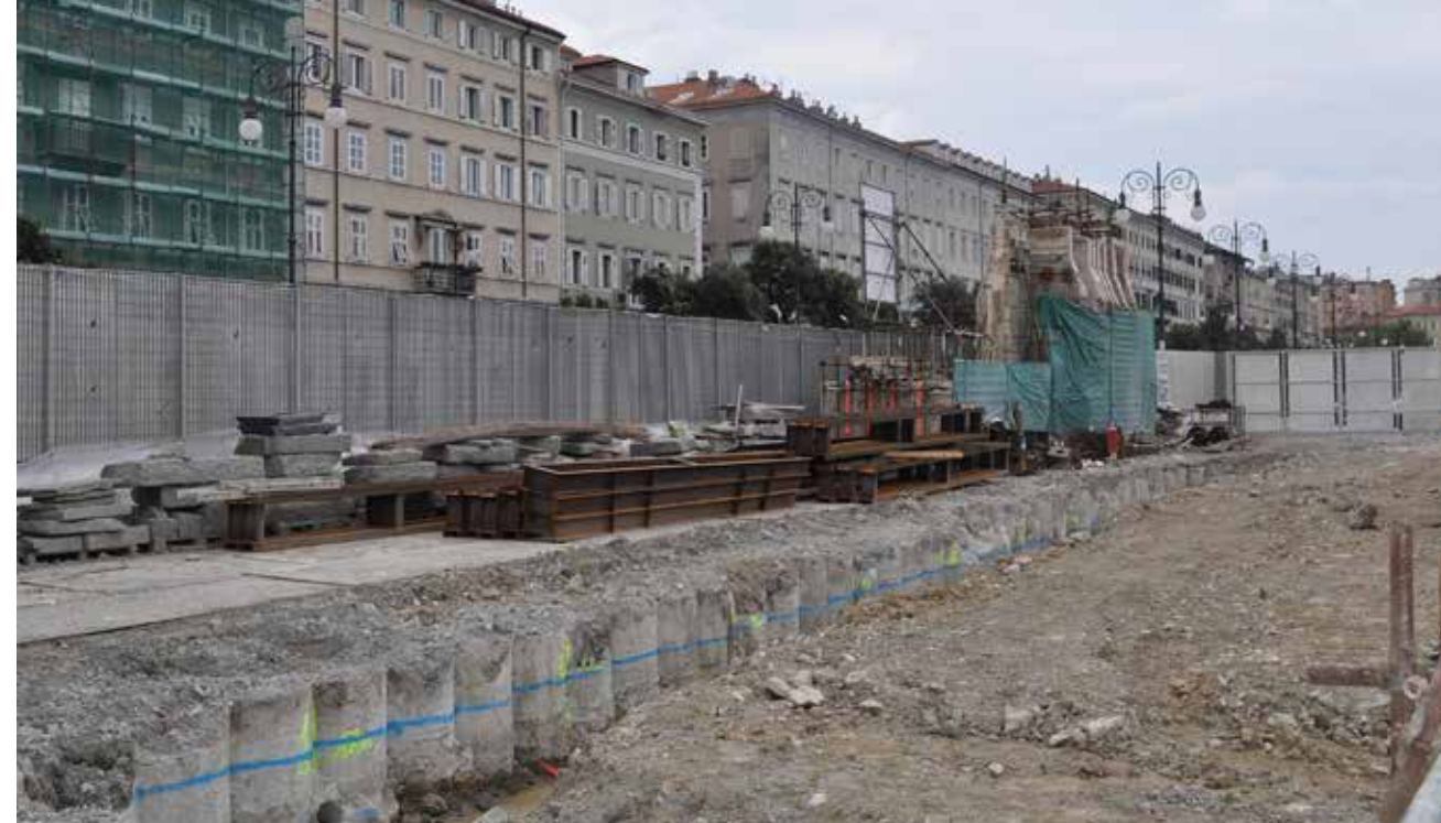
Esecuzione dei pali secanti, ammassati nel substrato roccioso, per il contenimento del terreno Execution of the secant piling, connected onto the layer of rocks to retain the ground
