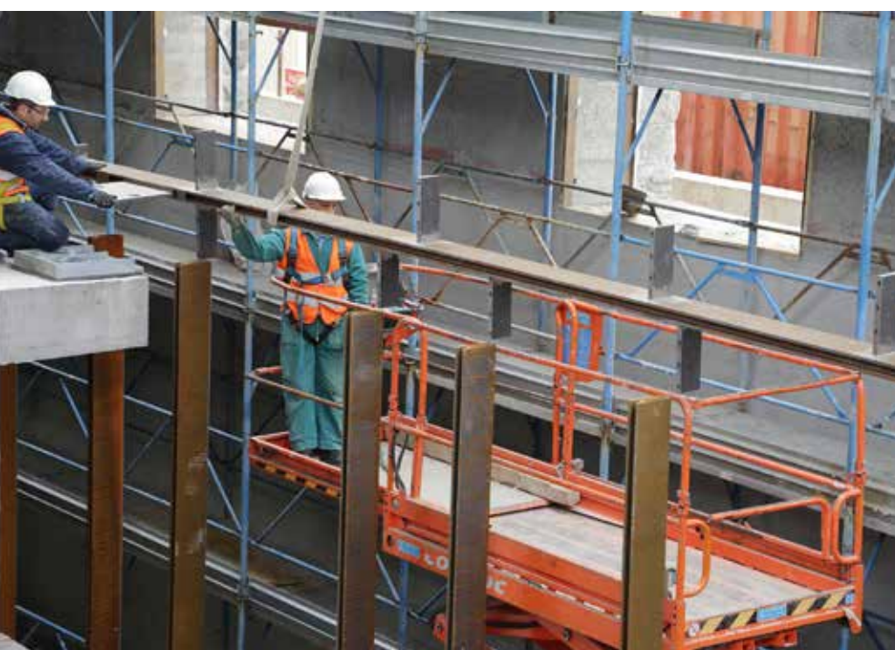
Montaggio delle carpenterie metalliche e del sistema in montanti e traversi per la realizzazione dell'involucro vetrato Installation of the metal carpentry and of the transoms and mullions system for the creation of the new glazed envelop
