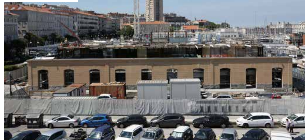
Realizzazione delle carpenterie metalliche di sostegno della pensilina vetrata in copertura Installation of the metal carpentry to support the glazed canopy on the roof
