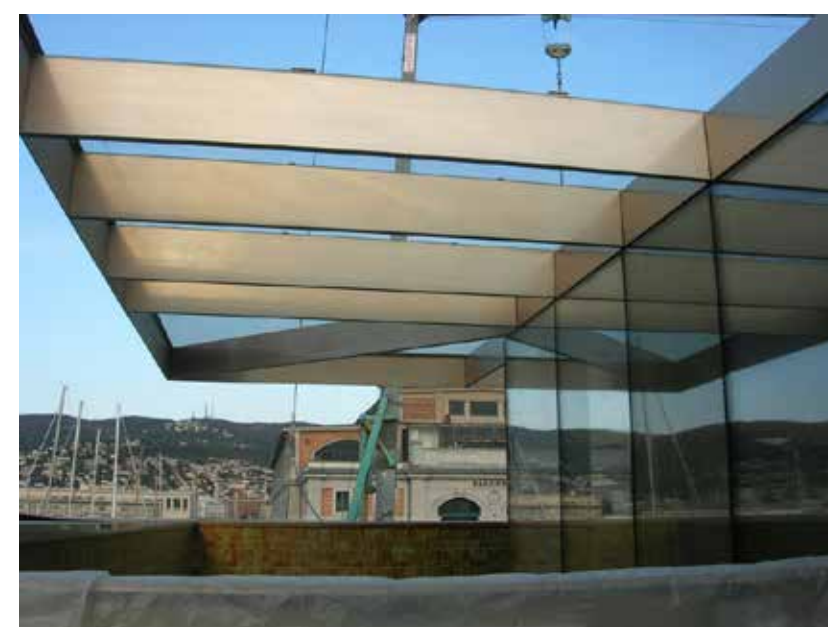
Completamento della pensilina vetrata, copertura dell'intercapedine tra l'involucro interno e i muri originari esterni Completion of the glazed canopy, cover of the gap between the internal envelop and the original external walls
