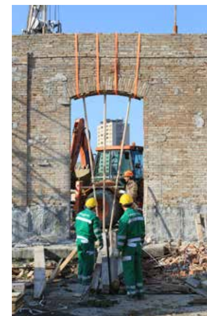
Imbragatura dei conci murari perimetrali da recuperare Binding of the wall blocks to restore
