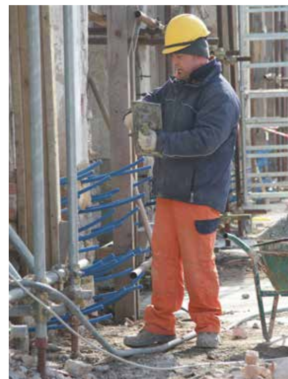
Iniezioni sul basamento di arenaria, funzionali al consolidamento statico delle murature Injections on the sandy base which were functional to the static consolidation of the walls
