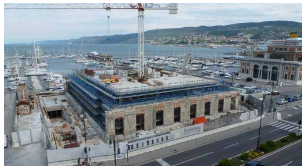
Rimontaggio delle murature preesistenti Re-assembly of the existing walls
