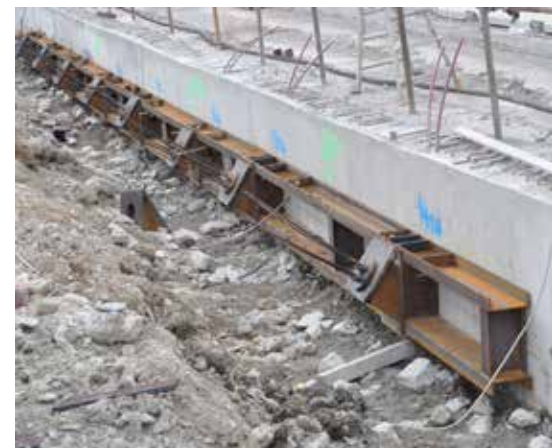
Esecuzione dei tiranti di tipo attivo a sette trefoli per vincolare in sommità la paratia di pali secanti Execution of the active seven threads rods to fasten the top of the wall to the secant piles
