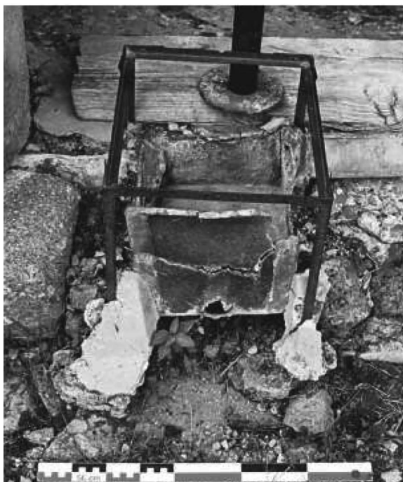
Fig. 5: Pompei, Casa di P. Paquius Proculus (I 7, 1): castellum plumbeum dal canale del portico Nord (da DESSALES 2013, fig. 132).
