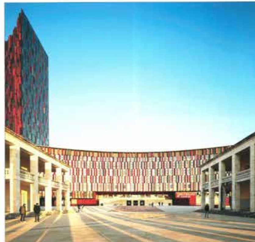
In alto scorcio del campo dalle gradinate, sempre delimitato da balaustrate in vetro. In basso, la piazza monumentale, nello stile italiano degli anni '30, che inquadra l'ingresso allo Stadio.
