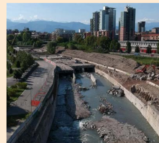
Cantiere dell'operazione di daylighting del fiume Dora Riparia. Crediti foto: La Repubblica.
