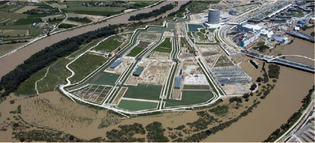
Il parco allagato in occasione di una piena nel 2015. Crediti foto: ParquedelAgua.
