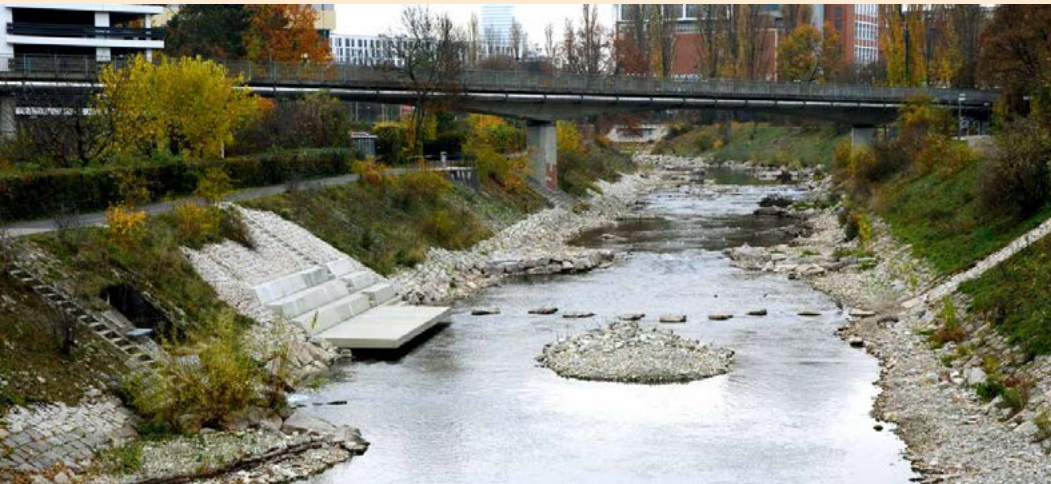
Nuovi argini del fiume Wiese. Crediti foto: Thommy Korrigiert.
