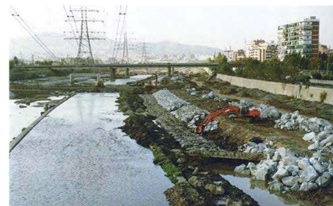
Cantiere per la realizzazione del parco. Sistemazione dei rinforzi in pietra. Alsina, J., Piulachs, M. (2002). Sant'Adrià de Besòs, Historia d'un canvi. Ajuntament de Sant'Adrià de Besòs. pp. 174.
