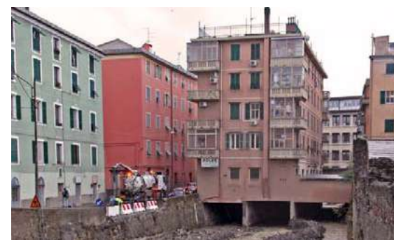
Genova Sestri Ponente, via Giotto, palazzina edificata sopra al torrente Chiaravagna. Demolita in seguito all'esondazione del corso d'acqua nel 2010. Crediti foto: Genova.repubblica.it.
