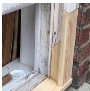
RIPARAZIONE DEL SERRAMENTO
