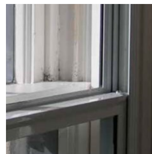
INSTALLAZIONE DI UN SECONDO SERRAMENTO
