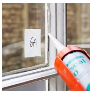
MIGLIORAMENTO DELLA TENUTA ALL'ARIA DEL SERRAMENTO
