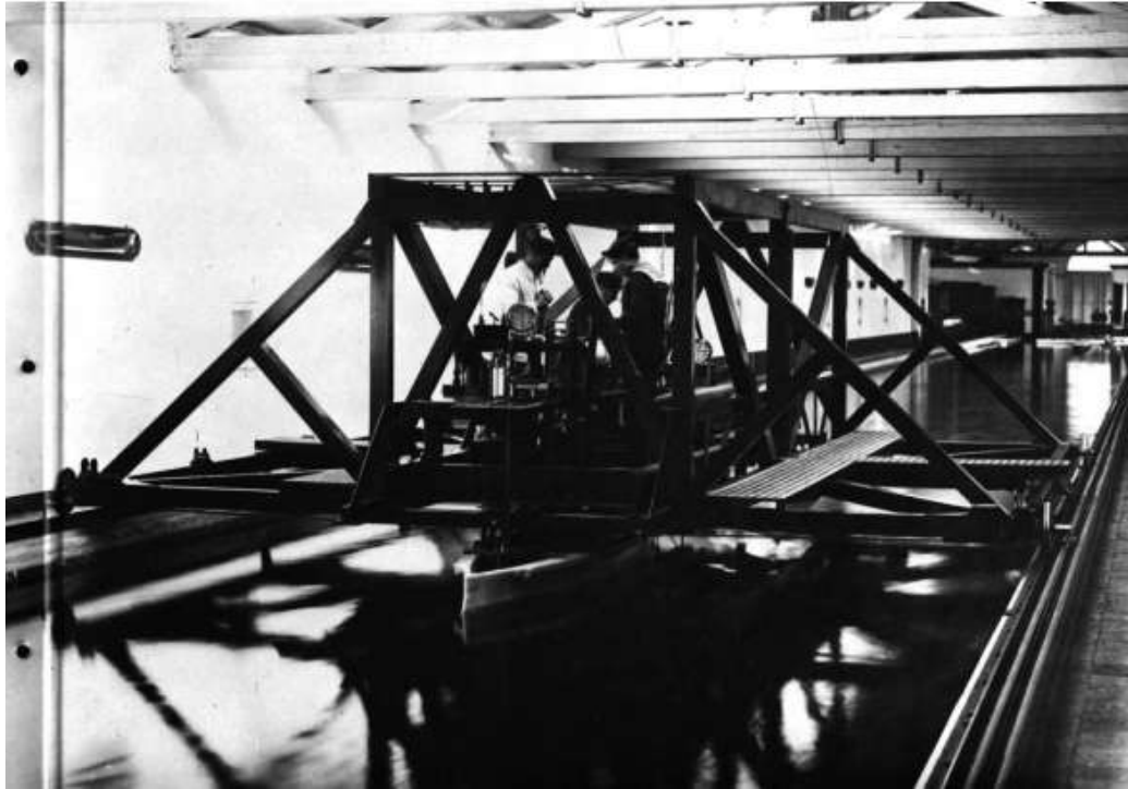
Immagine del carro dinamometrico per le carene della Vasca Navale della Spezia, ripresa nel corso di una prova di modello, g.c. Marina Militare
