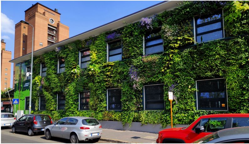
Fig. 5. Facciata verde del Deposito ATM di Milano Giambellino impiegata per il miglioramento della qualità dell'aria.
