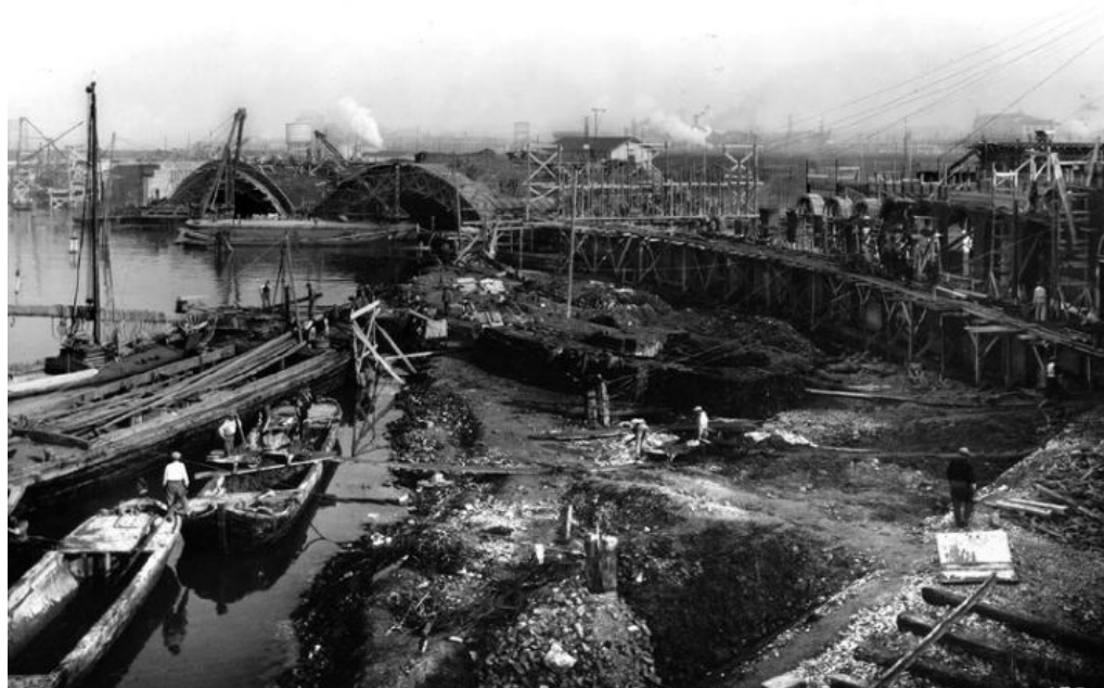
4: Ponte lagunare - Costruzione delle rampe a Venezia, 1932 [Archivio fotografico del Comune di Venezia, Fondo Giacomelli, identificativo immagine n. GN003240].
